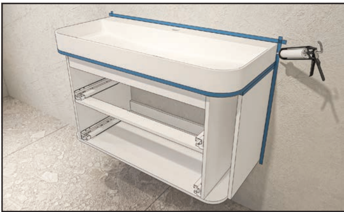
Afkitten tussen onderkast en wand/wastafel en wand/langs wastafel en onderkast
